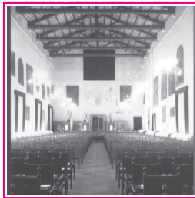
Salone papale di Rieti ricostruito per volontà del vescovo Massimo Rinaldi. Sono visibili le prime 5 delle 13 capriate del soffitto (le capriate prima dei lavori erano in numero di 19). Il secondo trave, a partire dalla parete di fondo, contigua alla Sala degli Stemma, porta la seguente iscrizione: «Tectum ex integro refectum anno MCMXXVI Maximo Rinaldi Episcopo» (Studio fotografico Controluce, di E. Ferri, Rieti)
