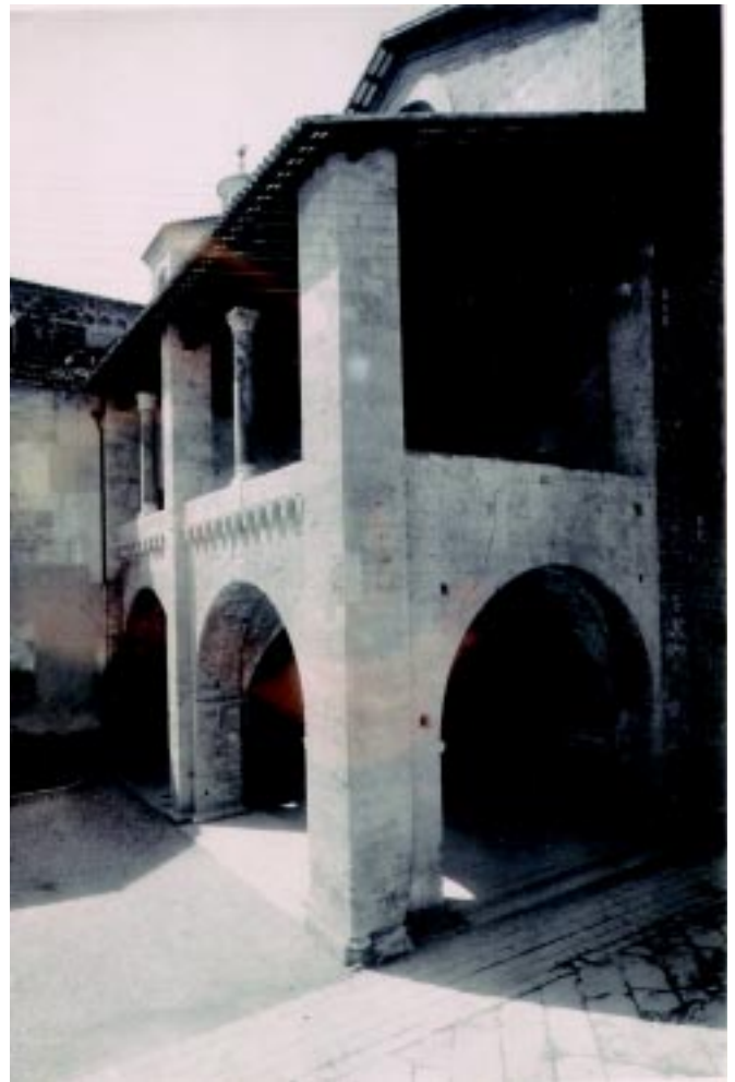
Loggetta e sottostante avamportico del palazzo papale di Rieti restaurati durante l'episcopato del venerabile Massimo Rinaldi (Archivio privato di Dario Brucchiotti, Rieti)
