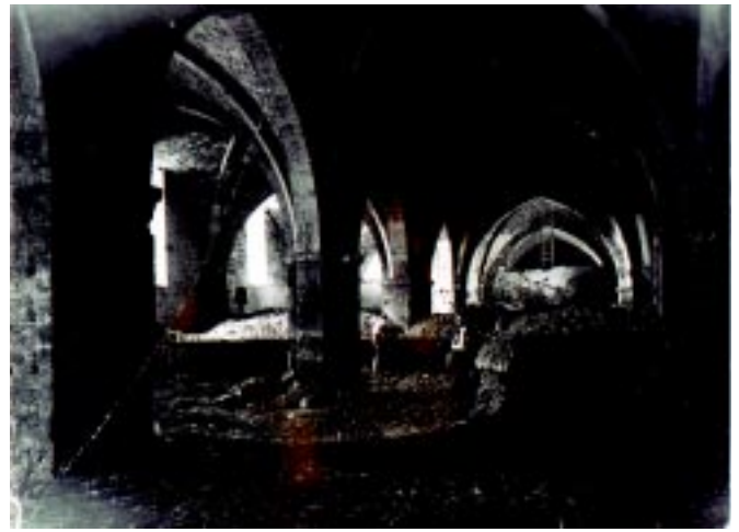
Le maestose volte del palazzo papale di Rieti all'inizio dei restauri voluti dal venerabile Massimo Rinaldi. La fotografia mostra in una panoramoca una fase dei restauri (Archivio privato di Dario Brucchiotti, Rieti)
