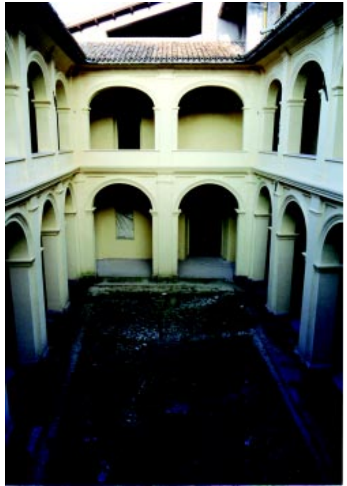
Monastero domenicano di S. Agnese di Rieti. Chiostro e loggia prima del completamento del restauro (ASAR)
